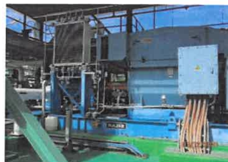
เครื่องสูบน้ำมันที่ติดตั้งเพิ่มเติม ภายหลังการเปลี่ยนแปลงรายละเอียดโครงการ
